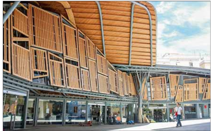
Santa Caterina ist die erste gedeckte Markthalle Barcelonas und wurde ursprünglich 1848 gebaut. 1997 begann die Renovierung. Miralles und Tagliabue setzten dem Gebäude ein neues Dach mit drei 42 m weit gespannten, freigeformten Bögendächern auf. Foto: Wikimedia Commons/Christine Zenino
