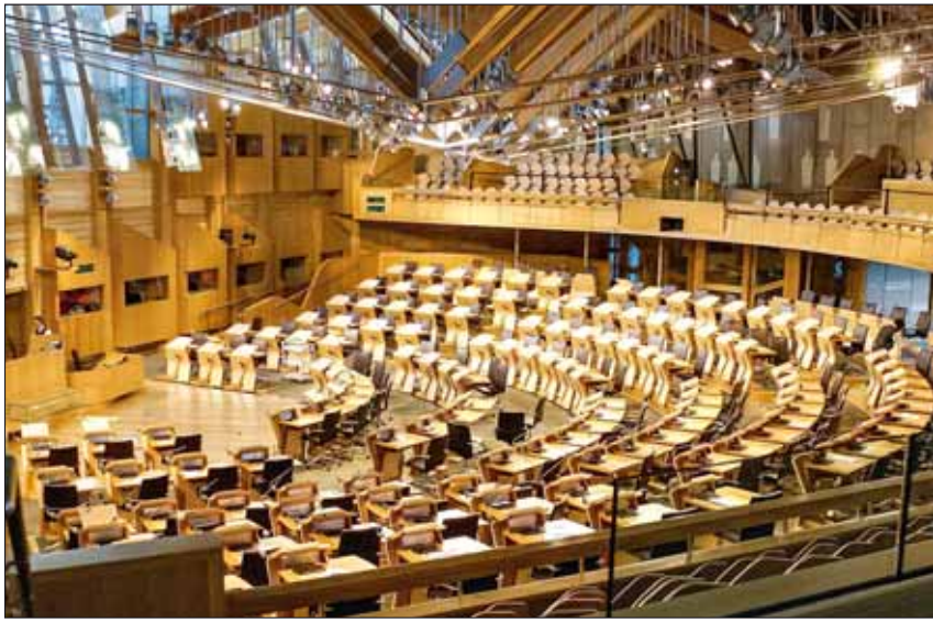
Die mit einer Stahlkonstruktion unterspannten Holzträger dominieren den Raum im Neubau des Schottischen Parlaments aus dem Jahr 1998. Foto: Wikimedia Commons/Mogens Engelund, Roskilde Dänemark
