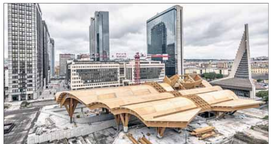
Gerade realisiert wird die Holz-Dachkonstruktion der „Centro Direzionale“, erdacht wurde sie vom Architekturbüro Miralles Tagliabue EMBT. Mit der Fertigstellung wird im nächsten Jahr gerechnet. Foto/Rendering: Paolo Fassoli
