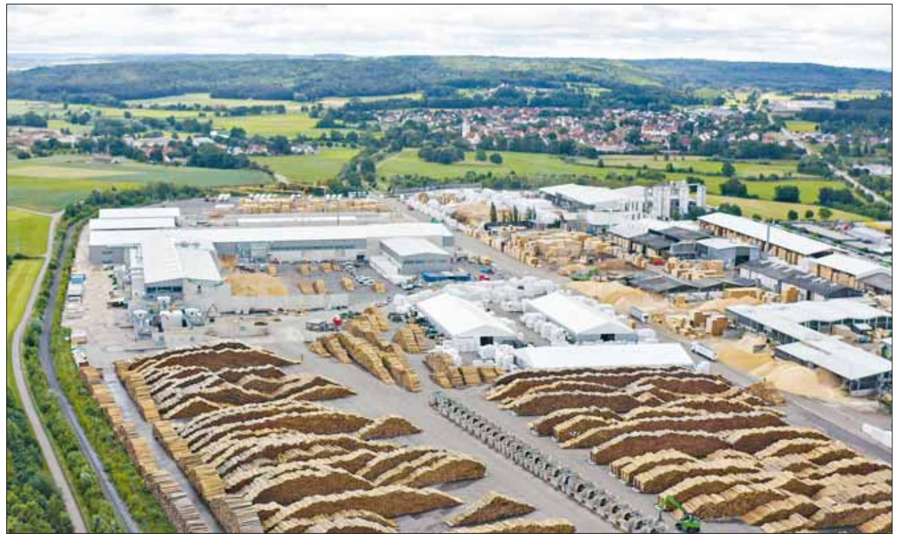
Ansicht des Rettenmeier-Standorts in Wilburgstetten Ende Juni: rechts der Werksstraße das Bestandssägewerk, links in der Bildmitte das neu errichtete Sägewerk und im Vordergrund der 2005 installierte Rundholzsortierstrang, der noch um 90 m bis zur Rundholzaufgabe (links) verlängert werden soll. Foto: Rudnick und Enners
